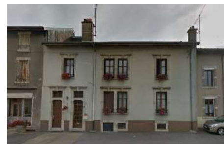
4. BA : Façade, 6 rue de Lorraine
