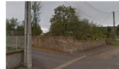
e6. Muret, rue du Maréchal Foch
