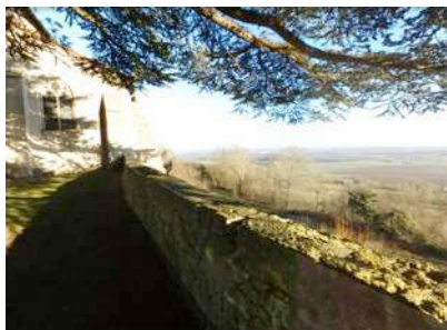
e7. Mur, place de l'Église
