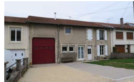
H. BA : Façade, 9 rue de Château Salins
