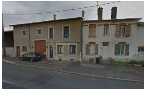
D. BA : Façades, 3-5 rue de Château Salins
