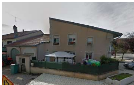
1. BR : Façade, 24 Grande Rue
