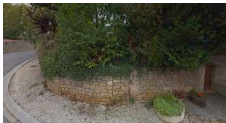
m2. Mur en pierre de l'église, rue du Chêne
