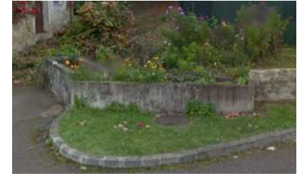
e. Fontaine, rue des Eaux
