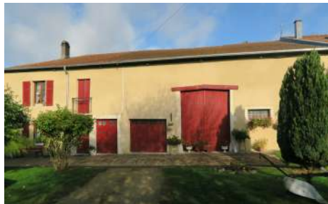
N. BA : Façade, 43 Grande Rue
