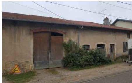
B. BA : Façade, 24 rue du Chaud Four
