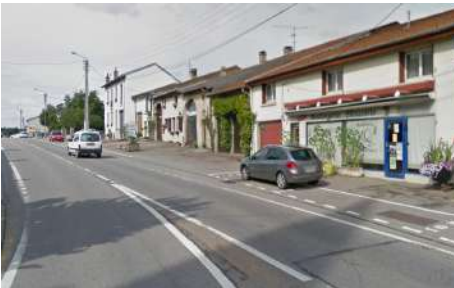
D. Alignement de façades, rue Saint-Barthélemy
