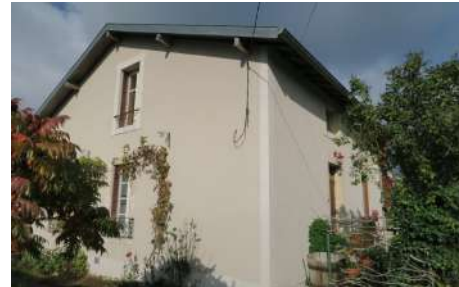
W. BR : Façade, 5 route de Moncel
