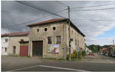
F. BA : Façade, place de la Mairie
