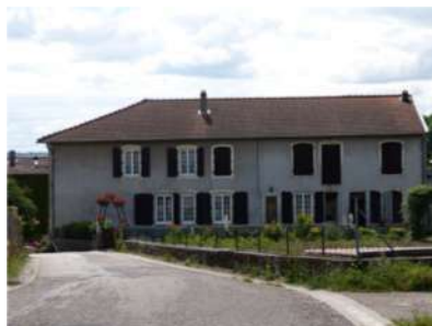
4. BA : Maison, 10 rue Saint Charles Ancienne maison de maître Chappé XVIIème
