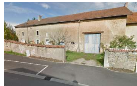
3. BA : Façade, 23 Grande Rue
