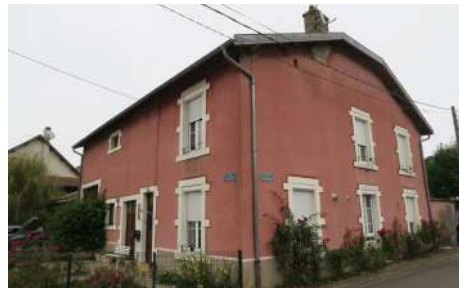
F. BR : Façade, 1 place de la Fontaine
