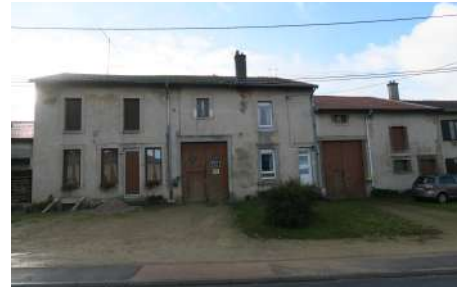
K. BA : Façades, 32-34 Grande Rue
