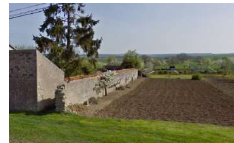
e. Muret, rue du Général Lambert
