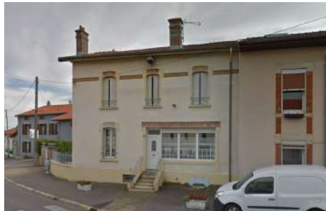
C. BR : Façade, 12 rue de Haguenau
