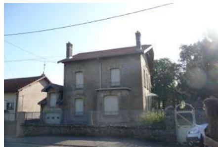
2. BR : Habitation, 40 rue Jean Mermoz Qualité de la composition et des modénatures de la façade façade. Portail, muret et grille de clôture d'origine
