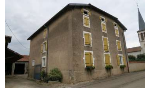
I. BA : Façade, 82 rue du Pont Lalaie
