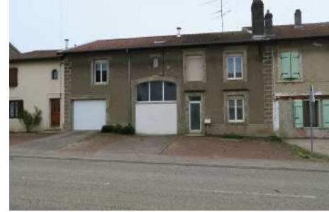
K. BR : Façade, 25 rue du Général Mathis
