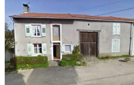
E. BA : Façades, 10-12 rue Haute
