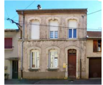
4. BA : Immeuble, 16 rue de l'armée Patton
