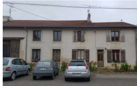
K. BA : Façade, 12 rue du Chaud Four
