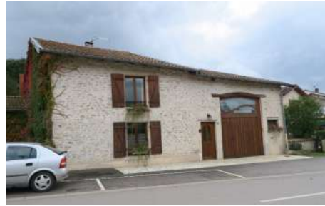
F. BR : Façade, 36 Grande Rue
