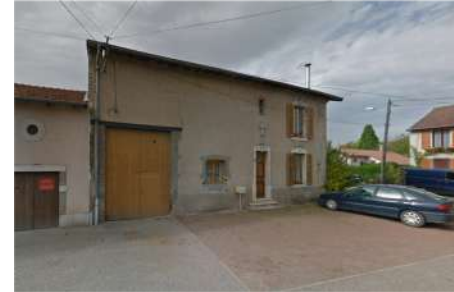
3. BA : Façade, 16 rue du Général Mathis
