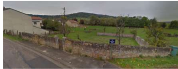
e2. Muret, rue du Maréchal Foch
