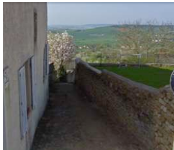
e1. Mur, 7 rue Saint Jean
