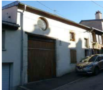
B. BR : Ferme, 37 rue du gen. Leclerc
