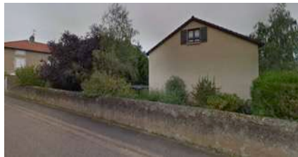
e4. Muret, rue du Maréchal Foch
