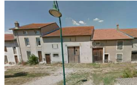
H. BA : Façades, 19-21 Grande Rue
