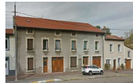
5. BA : Façade, 7 rue de Lorraine
