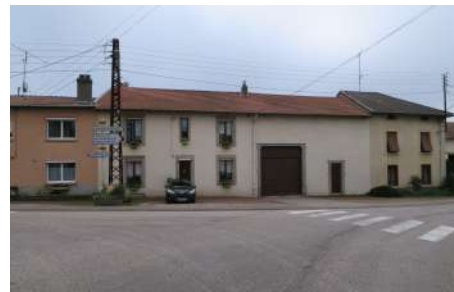
10. BA : Façade, 13 rue du Général Mathis
