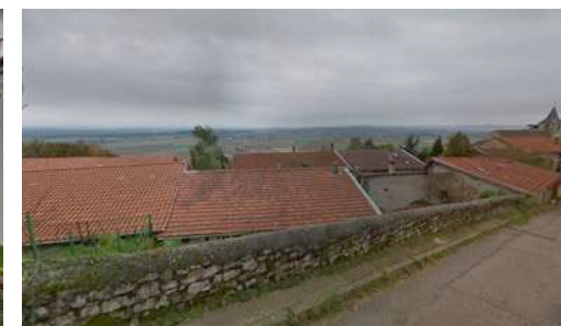
e17. Mur, rue du Grand Mont
