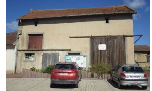
F. BA : Façade, rue Haute
