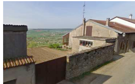
e2. Mur, 17 rue Saint Jean
