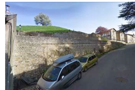
e5. Mur, rue Saint Jean
