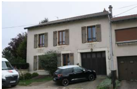
F. BR : Façade, 28 rue du Docteur Grandjean
