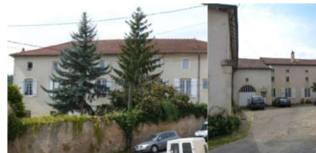
6. BA : Ensemble de bâtiments, 3 rue de la Vierge
