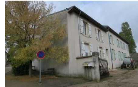
D. BR : Façade, 6 rue de Velaine
