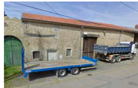
D. BA : Façades, 85-87 rue Saint-Nicolas
