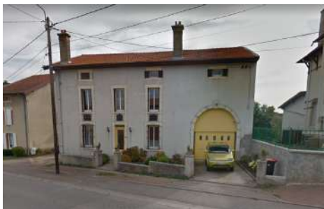
B. BR : Façade, 18 rue de Haguenau
