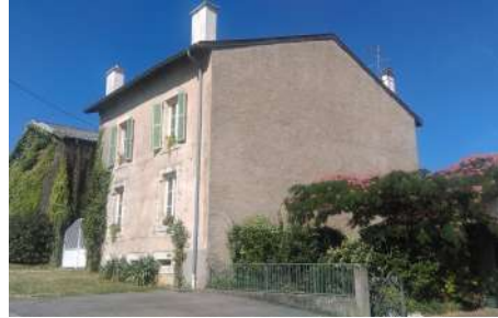
B. BR : Façade, 8 rue du Grand Couronné
