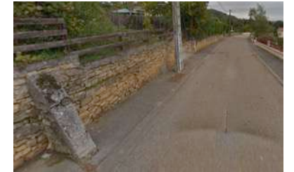
h4. Mur en pierre, 49 route de Blanzey
