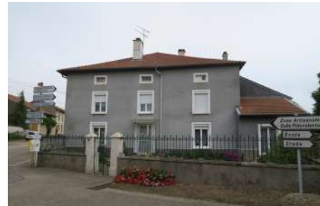
11. BR : Façade, 1 rue du Général Mathis
