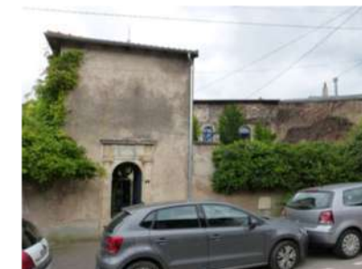
7. BA Ensemble de bâtiments, 1 rue du Chêne
