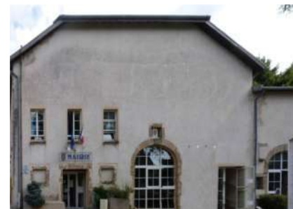
3. BA : Mairie, 4 rue Jules Ferry :Ancienne ferme
