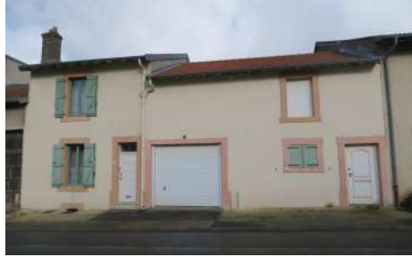
R. BA : Façade, 61 Grande Rue
