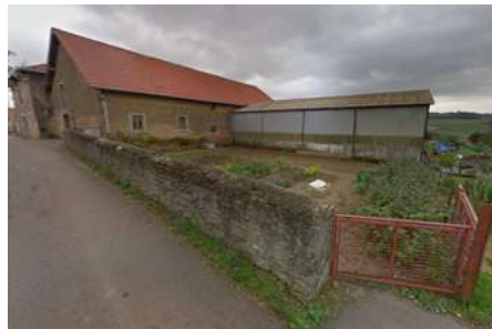
d2. Mur en pierre, ruelle Ferrée
