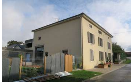
6. BR : Façade, 67 Grande Rue
