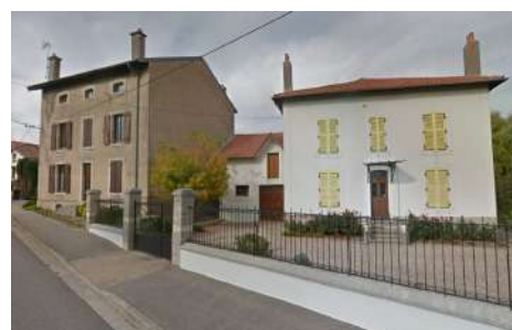
J. BR : Façades, 5-7 rue de Haguenau
