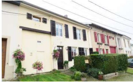
F. BR : Façade, 20 Grande Rue
