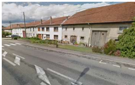
E. Alignement de façades, rue de Château Salins
