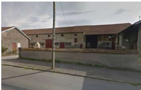
A. BA : Façade, 18 rue de Château Salins
