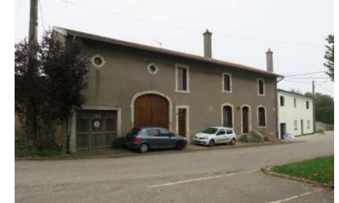
4. BR : Façade, 2 rue de l'Eglise
