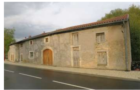
C. BA : Façade, route de Voirincourt
