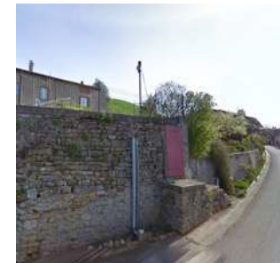
e3. Mur, rue Saint Jean
