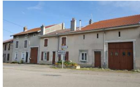
H. Alignement de façades, rue Hanzelet
