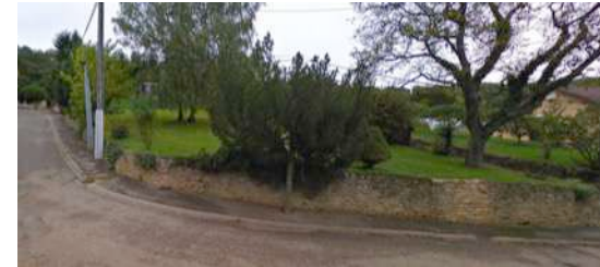
h3. Mur en pierre, 49 route de Blanzey
