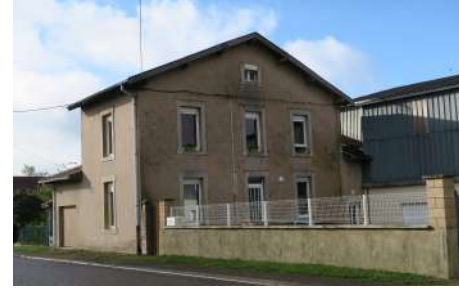
T. BR : Façade, 1 route de Moncel
